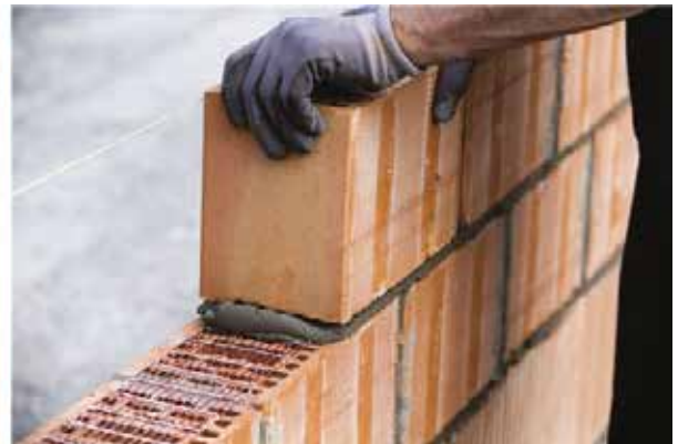
Sonraki duvar bloğunu yerleştirin
