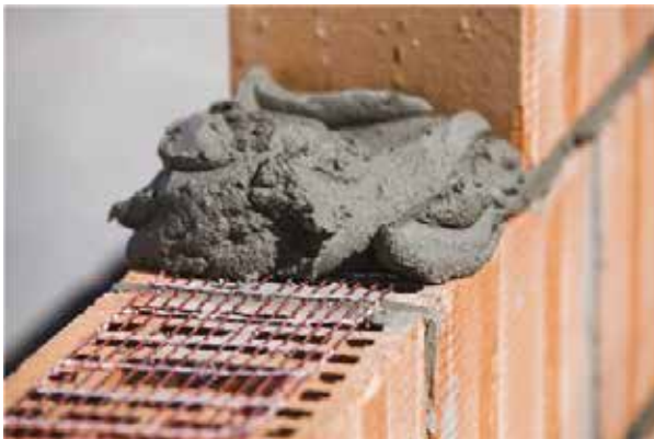
Duvar bloklarına bir tabaka halinde harç uygulayın
